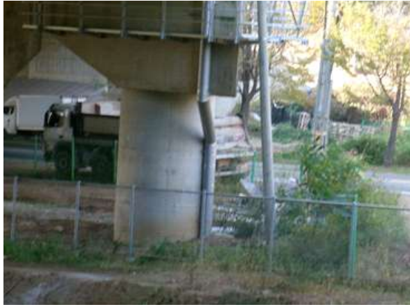
교각 P1 기둥부 상태양호
