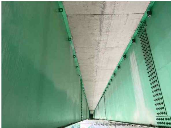
바닥판 하면 S2 상태양호
