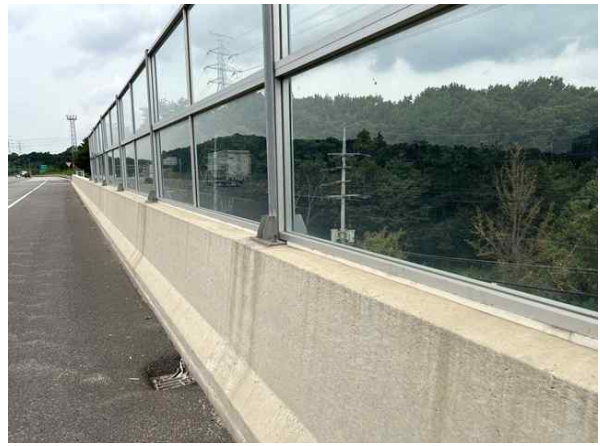
방호벽 S2 상태양호
