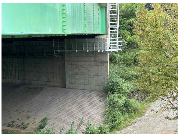
교대 A2 상태양호
