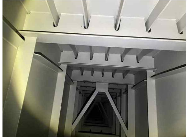
거더내부 S2 상태양호
