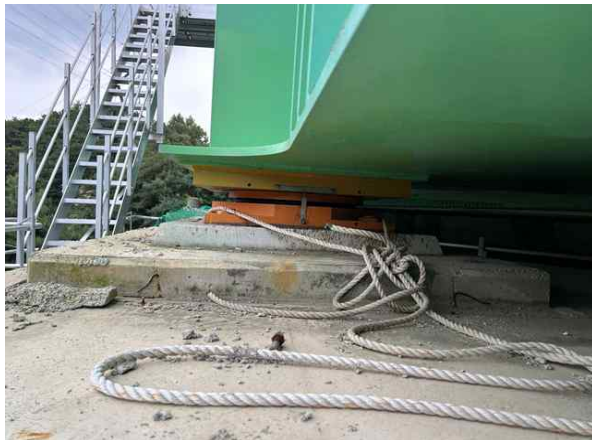
교량받침 P1-Sh2 상태양호
