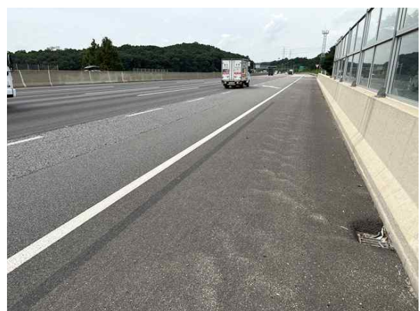
교면포장 S2 상태양호
