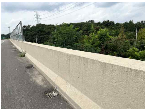
방호벽 S1 상태양호
