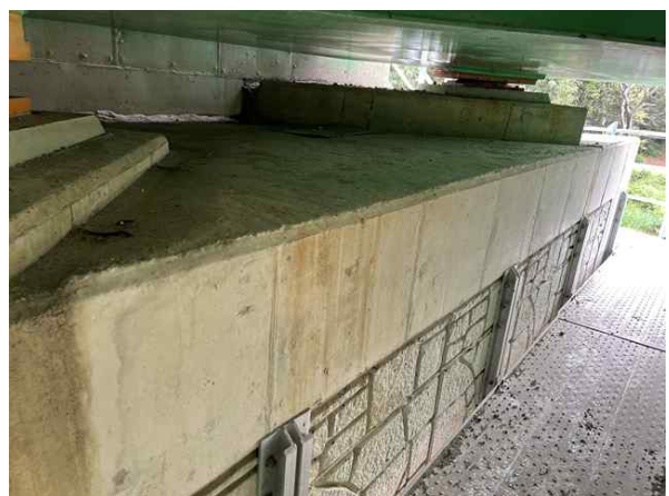
교대 A2 상태양호
