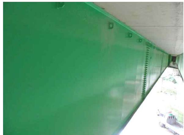
거더외부 S2 상태양호
