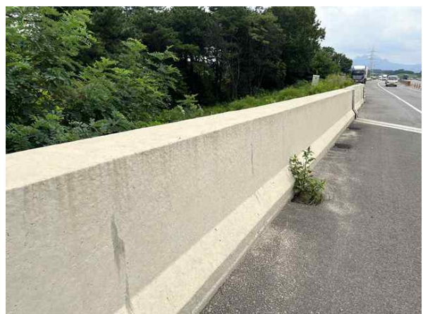
방호벽 S1 상태양호
