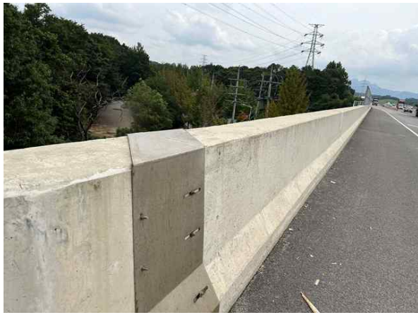
방호벽 S2 상태양호
