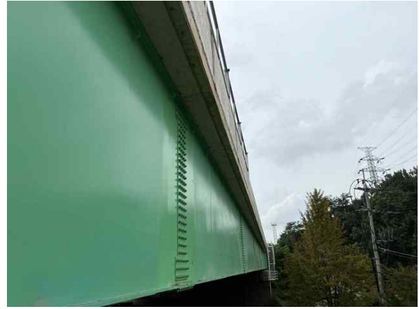
바닥판 하면 S1 상태양호
