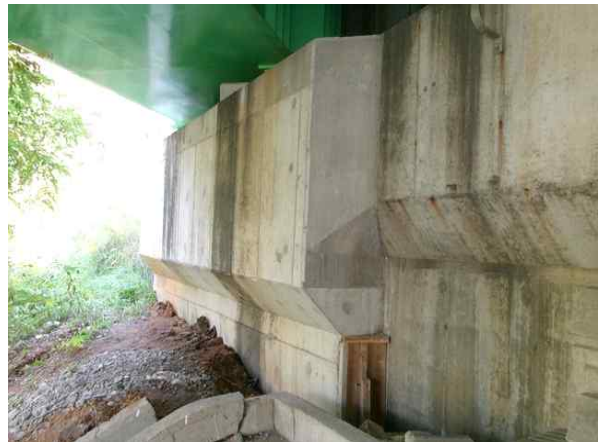
교대 A1 상태양호
