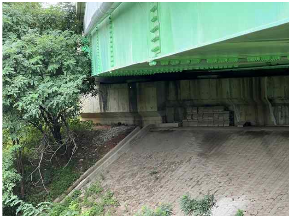
교대 A1 상태양호
