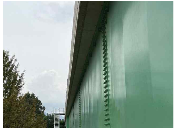
바닥판 하면 S2 상태양호
