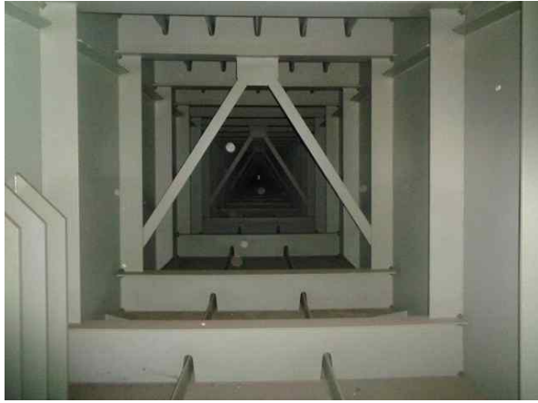
거더내부 S1 상태양호
