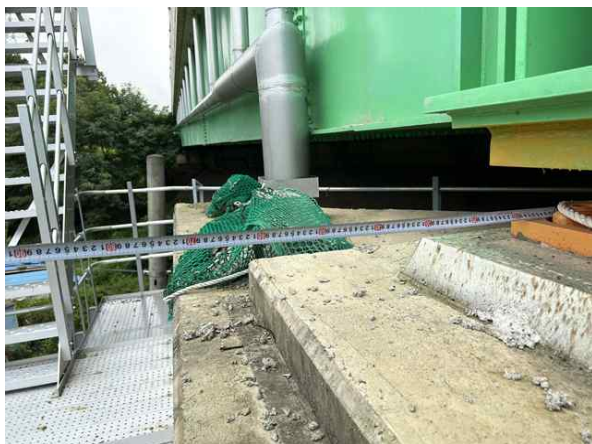
받침장치 연단거리 측정
