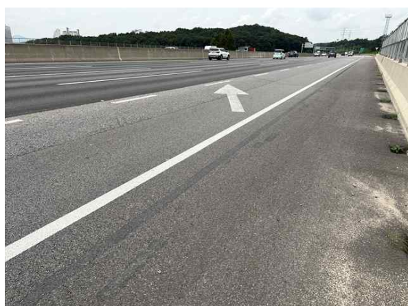
교면포장 S1 상태양호
